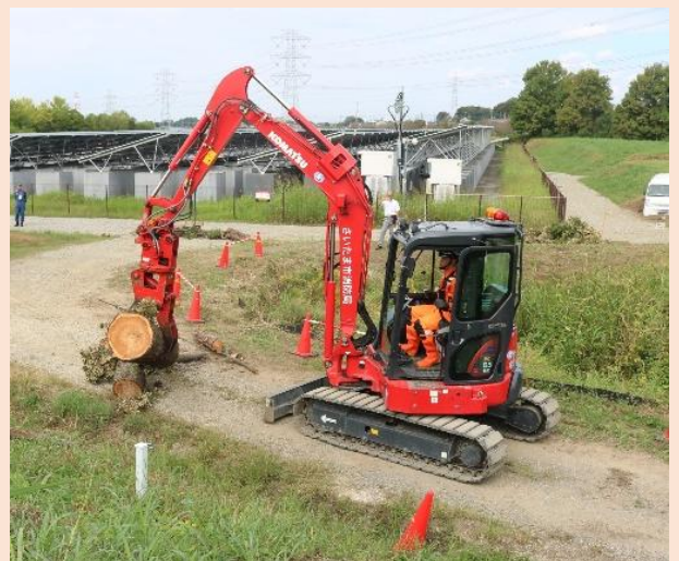
重機で倒木の排除を行う
